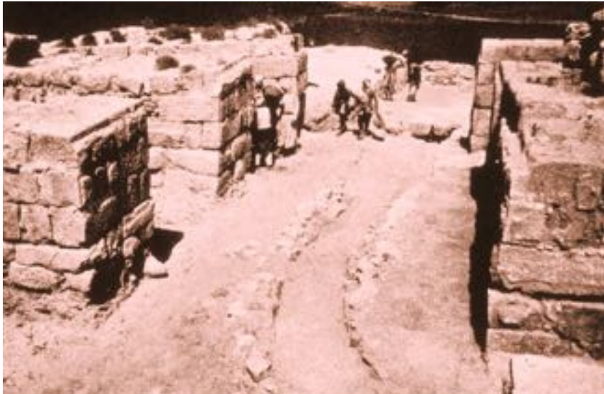
Puerta de Meguido antes del desmonte de un lateral
