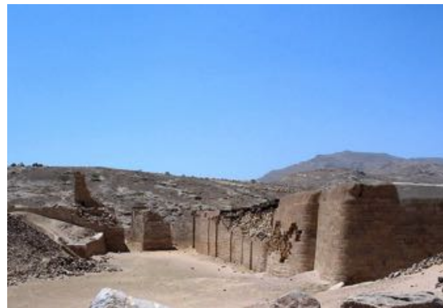
Presa de Al-Mabna
