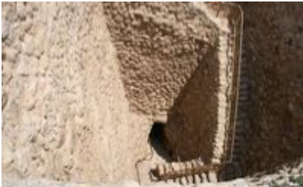
Entrada a las cisternas subterráneas
