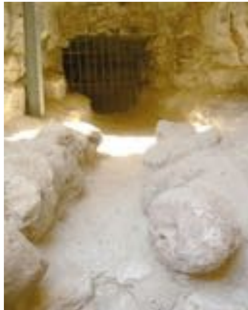
Boca del túnel de recogida de agua del arroyo Nahal Hebrón
